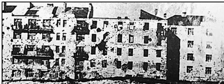
Частично разрушенные дома портовиков
